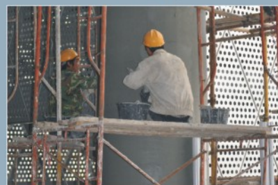
批清水混凝土STUCCO
